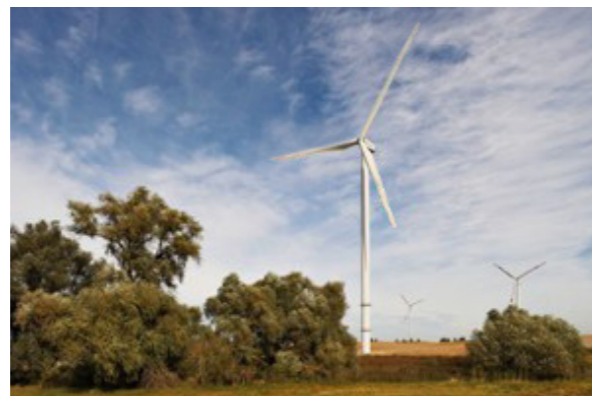
Fig. 67 : Éolienne NORDEX NI 17
